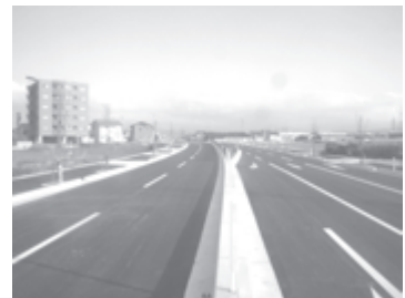
焼却灰入りアスファルト舗装
